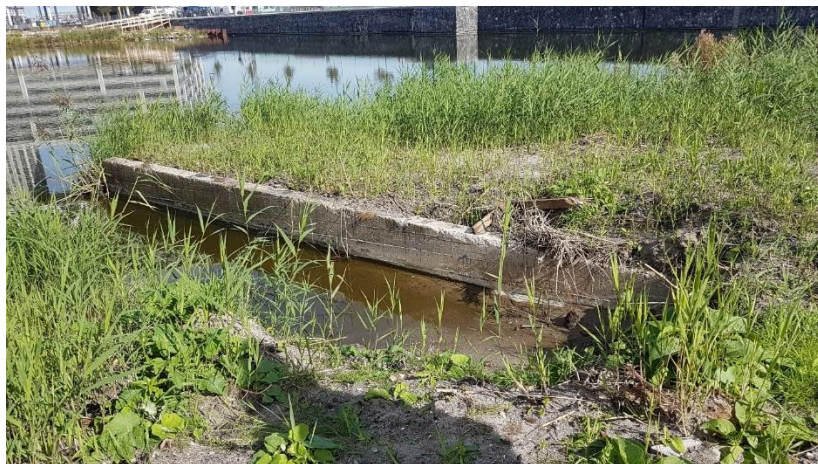
Foto d.d. 25-09-2018 Locatie te bouwen kademuur
