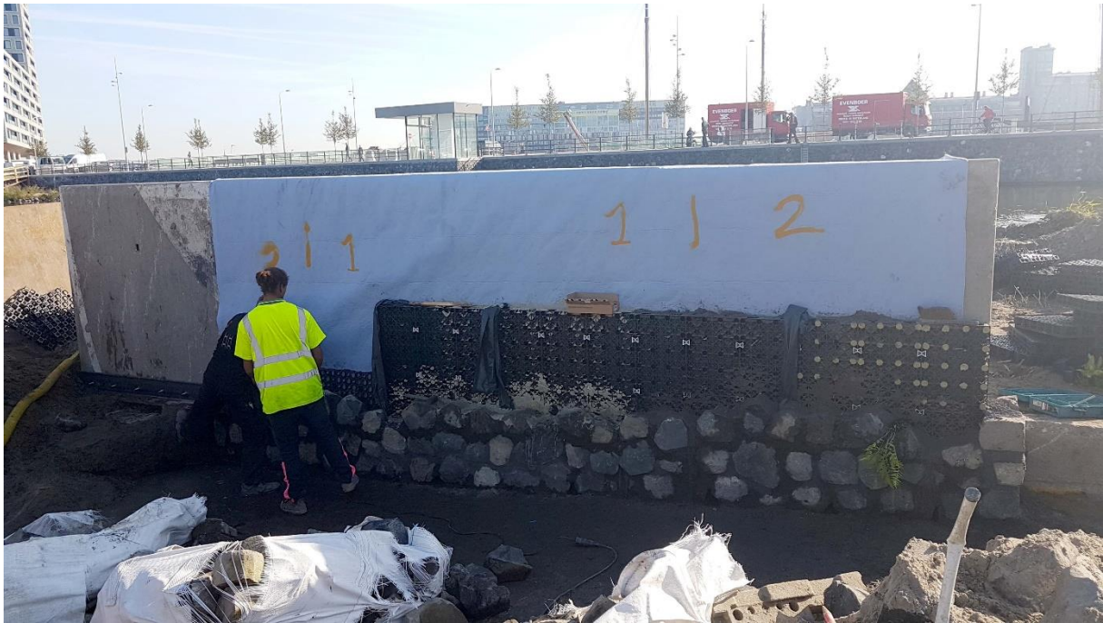
Foto d.d. 05-10-2018 Betonplaten, kratten en metselwerk basaltkeien
