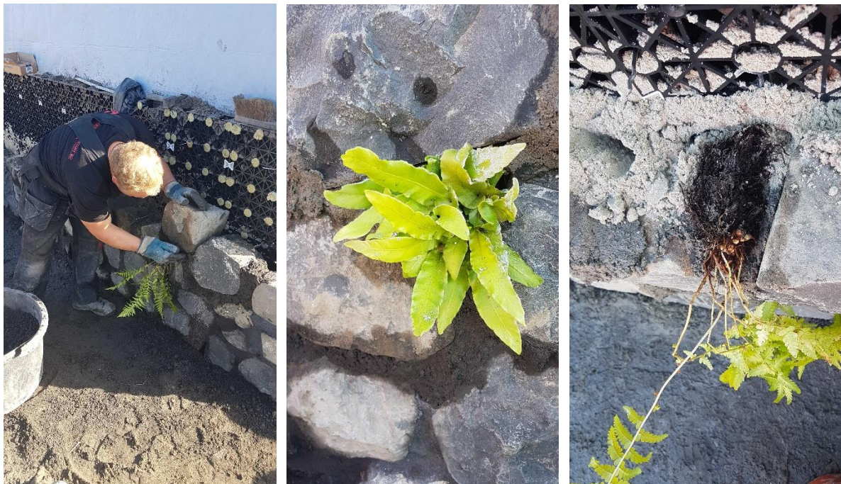
Foto d.d. 05-10-2018 Aanbrengen beplanting
