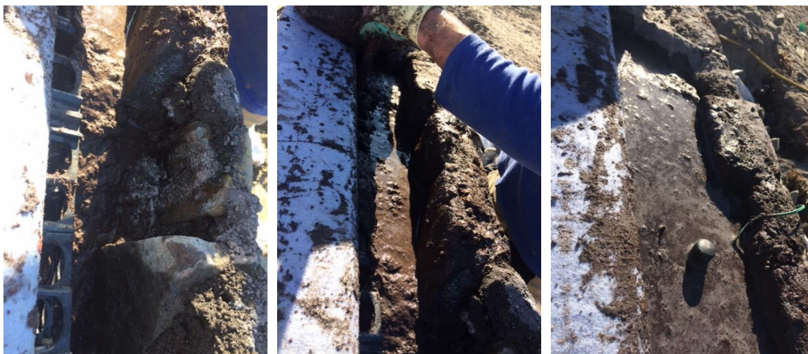
Foto's d.d. 10/11-10-2018 Aanbrengen BVB substraat
