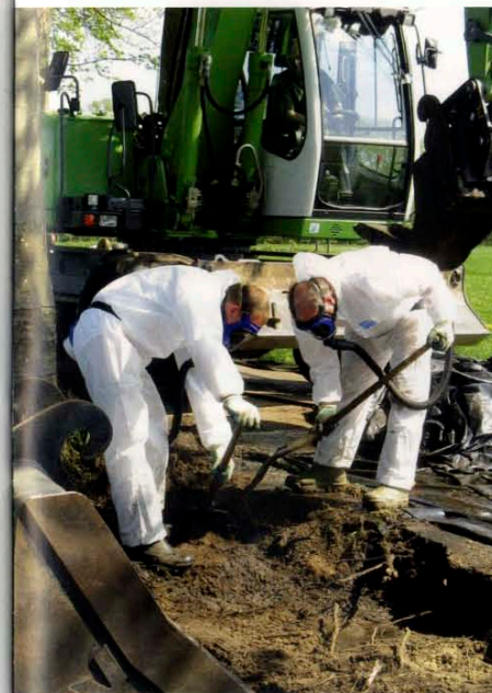
Dichtbij de stam wordt met de hand gegraven. Met de kraan is de kans op het beschadigen van wortels te groot.
