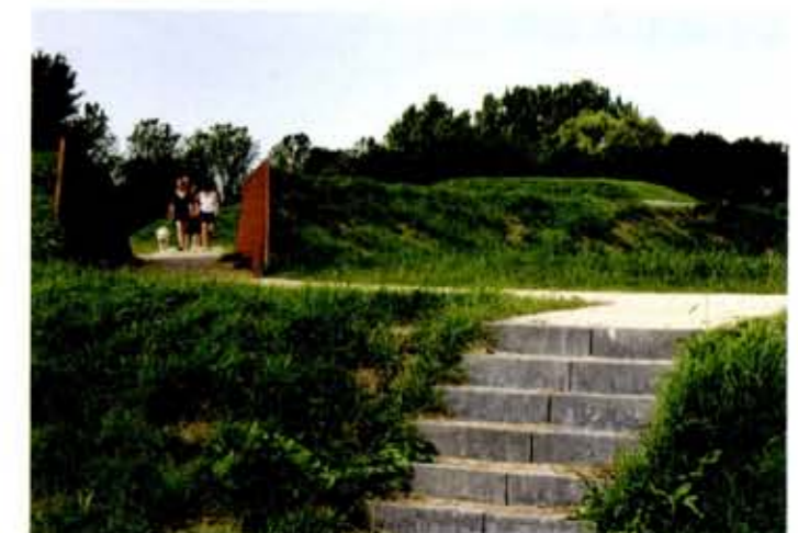
Betonnen trap naar een plek aan het water.
