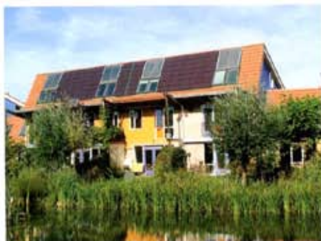
Some energy measures, such as the solar panels, are clearly visible. Others, like energy recovery from biomass, remain hidden. The target for Lanxmeer is an energy consumption of no more than 40 gigajoules per household. Sommige energiemaatregelen, zoals de zonnepanelen, zijn duidelijk zichtbaar. Andere, zoals de energiewinning uit biogas, blijven voor het oog verborgen. Lanxmeer streeft naar een energieconsumptie van maximaal 40 gigajoule per woning.
